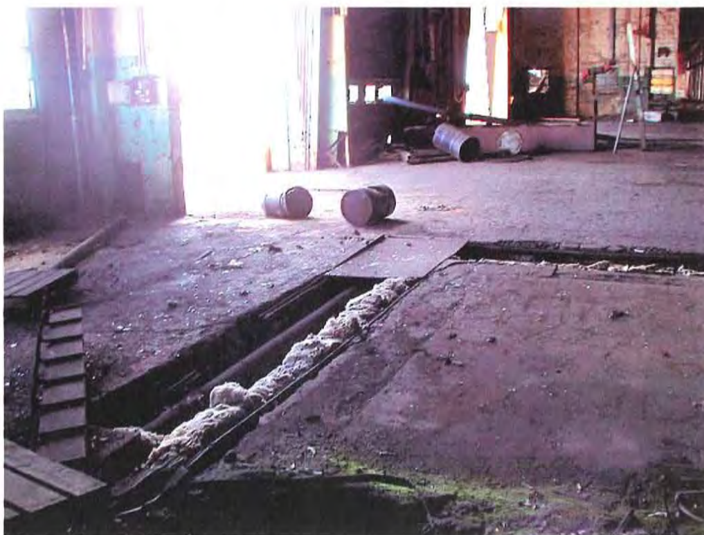
Réseau de drainage intérieur. 1 mètre de largeur par 1 mètre de profondeur, sur près de 400 mètres de longueur.
