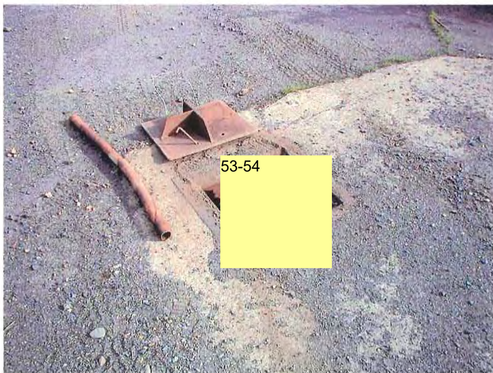
Trou d'homme situé au nord-est du garage comportant des jonctions de conduites destinées à l'alimentation en eau potable.
