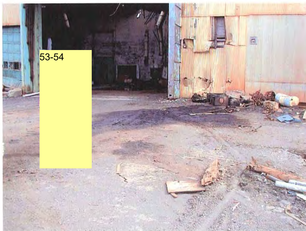
Présence d'une superficie de 50 m 2 de sol contaminé sur 0,04 m de profondeur à droite de la porte principale du garage.
