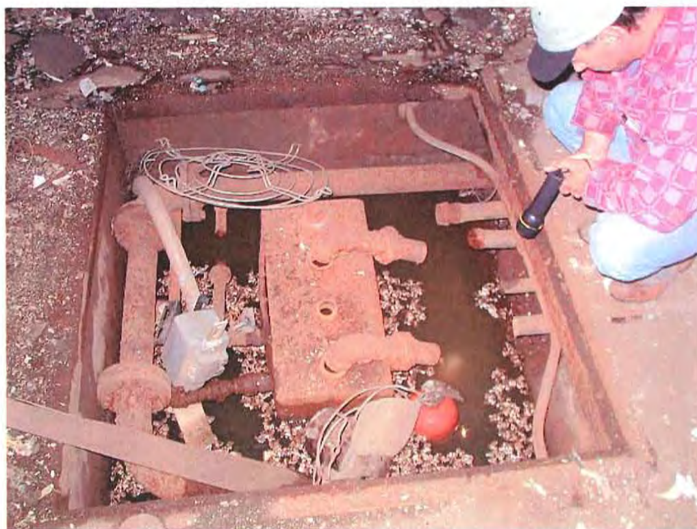
Fosse ayant fait l'objet de la prise d'échantillon "garage#2". Une très faible concentration en hydrocarbures fut retrouvée (0,1 ppm).
