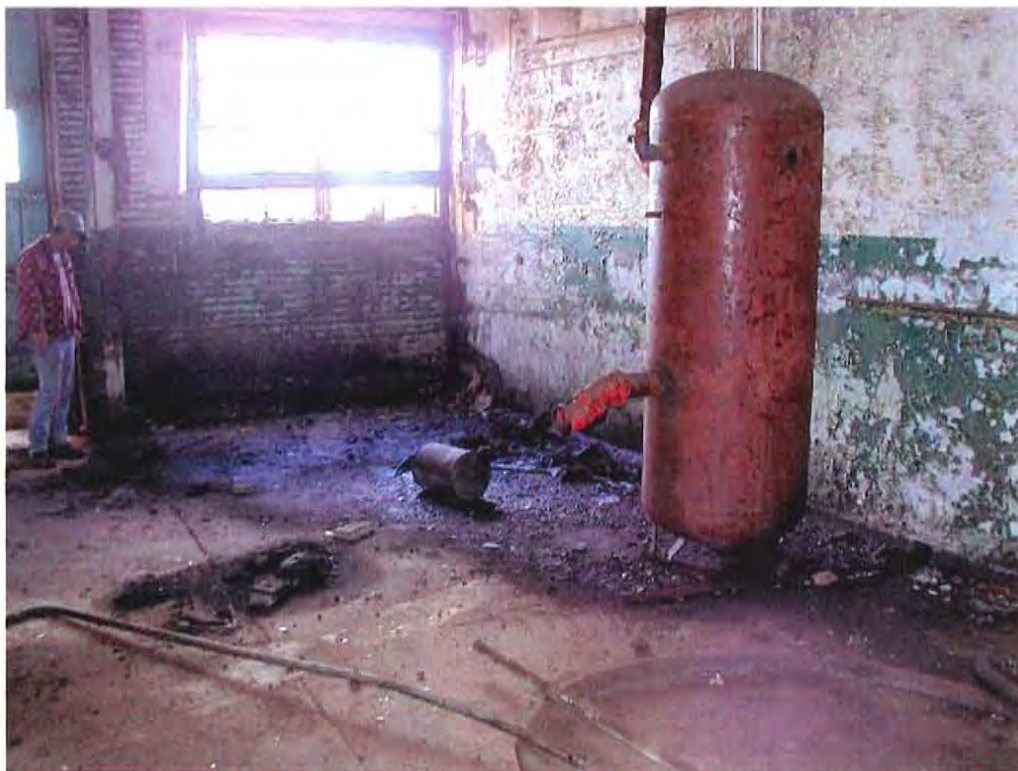
Réservoir d'huile déversé sur le plancher du garage, \pm 35 \text{ m}^2 de surface contaminée.
