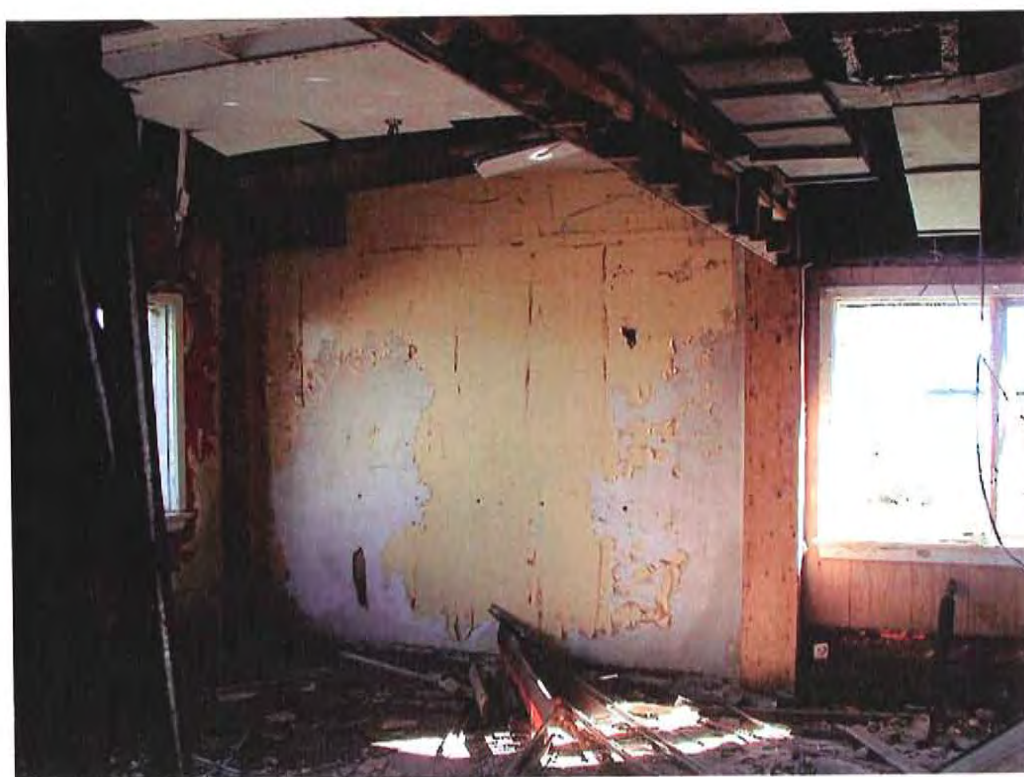
Photographie prise au deuxième étage du bâtiment démontrant l'état de la peinture. L'échantillon de celle-ci confirme la présence de plomb.
