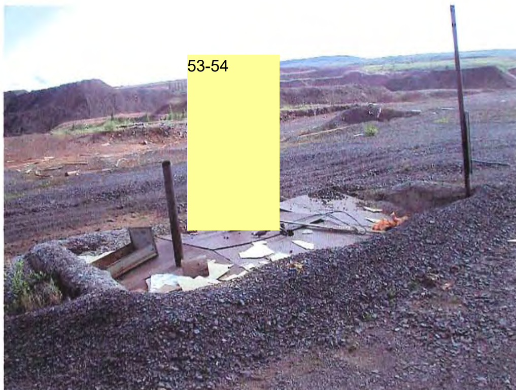
Emplacement d'un réservoir souterrain à proximité du garage. Ce dernier ne comportait pas de liquide mais des odeurs d'hydrocarbures s'en dégageaient.
