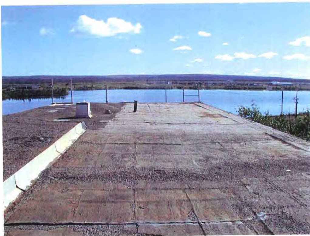
Vue de la toiture. Remarquez l'affaissement entre la poutrelle centrale et la bordure droite de la toiture. Remarquez également les fissures à certains endroits occasionnant l'infiltration d'eau.
