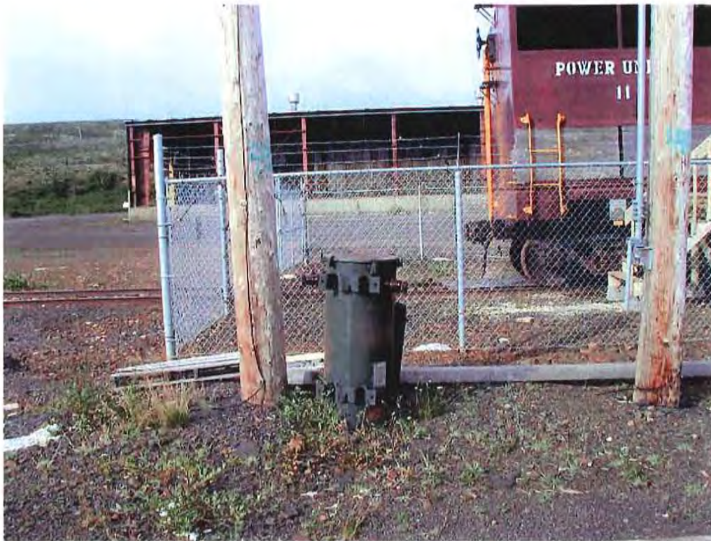
Transformateur se trouvant à proximité du groupe électrogène mobile. Il s'agit d'un transformateur de marque Ferranti-Packard de 75 KVA contenant 28 gallons imp. d'huiles et datant de 1969. Grande possibilité d'y retrouver des huiles contaminées aux BPC.
