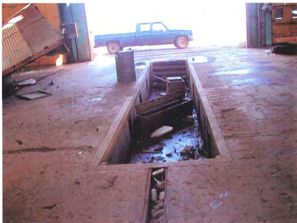
Photographie du trou d'homme prise à l'intérieur du garage et démontrant des traces évidentes de contamination par des hydrocarbures.
