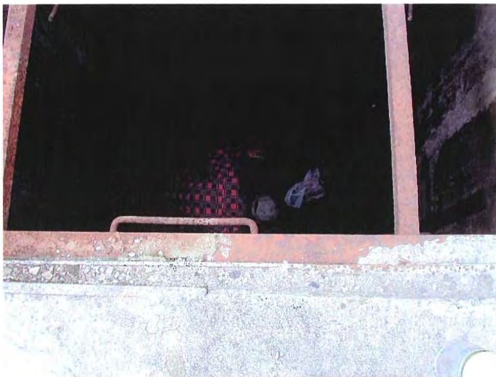
Trou d'homme situé au nord du garage comportant des sols et de l'eau fortement contaminés par des hydrocarbures. Fosse raccordant probablement les drains de planchers.
