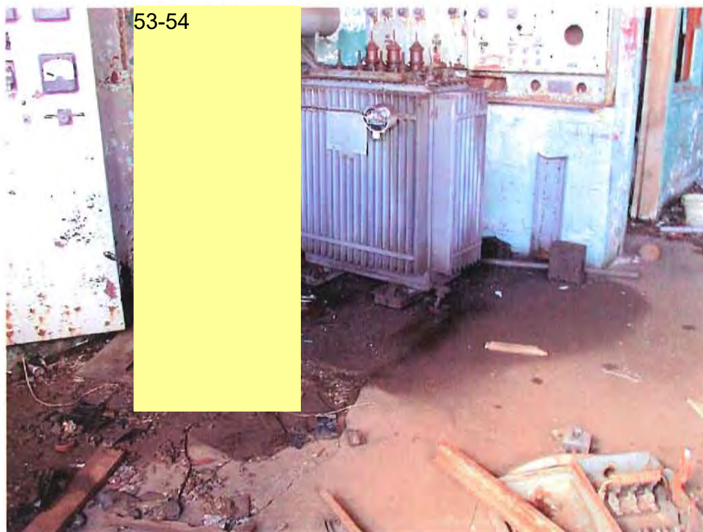
Transformateur de 82 gallons impériaux s'étant vidé sur le plancher. Ce dernier se retrouve du côté nord dans une pièce située au centre du garage.
