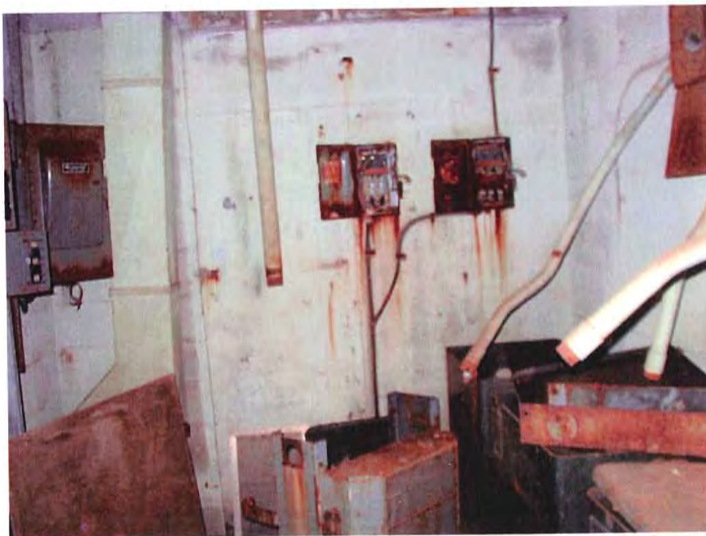
Vue de l'emplacement au sous sol où se trouve les transformateurs. L'échantillon prélevé à cet endroit confirme la présence de BPC sur le sol.
