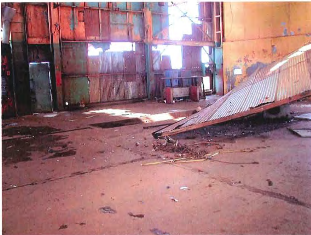
Vue du mur ouest et d'une section de la toiture effondrée démontrant l'état de la structure.
