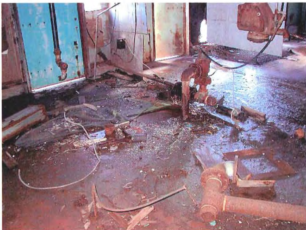
Chambre de distribution des huiles et des graisses situé a l'intérieur du garage. Le plancher démontre une contamination de 150 m 2 de surface.
