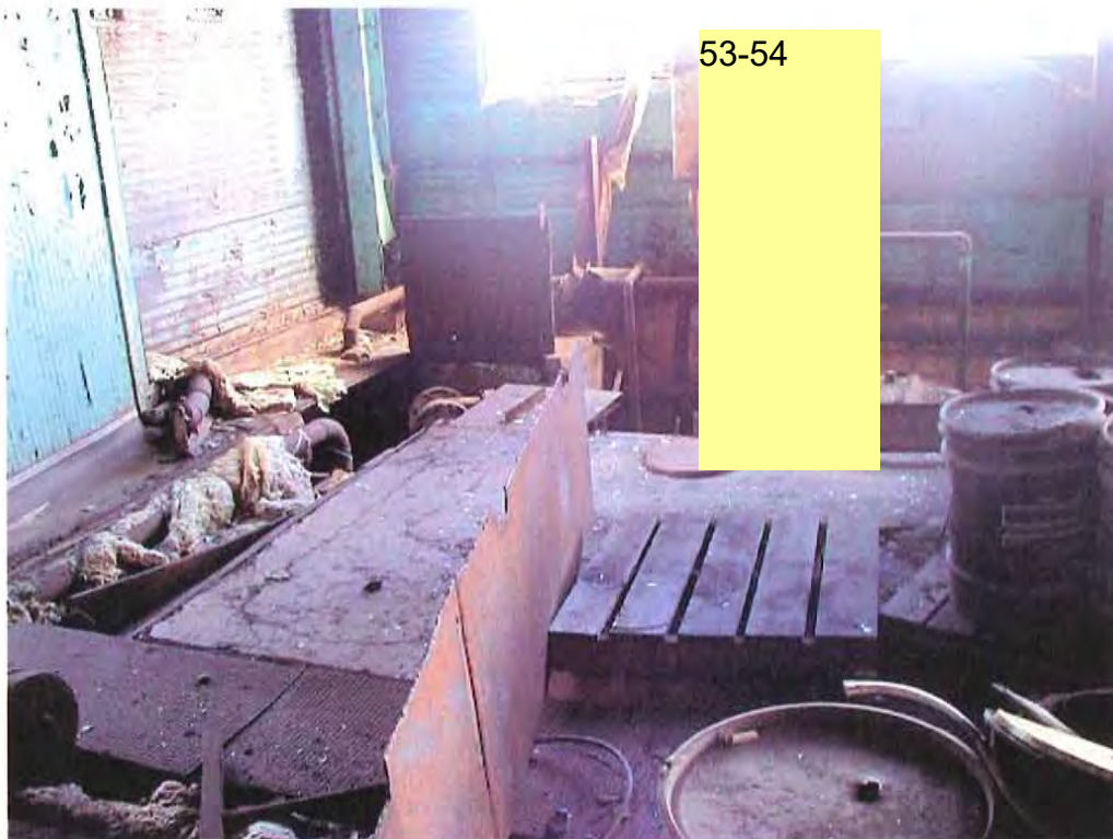
Fosse à l'extrémité du réseau de drainage, coin nord-est du garage. La fosse contient des hydrocarbures en phase flottante.
